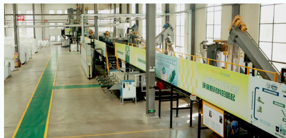
金发科技塑料餐盒回收和再生利用示范线
